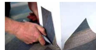
6. Lorsque le matériau est bien à plat au niveau des raccords et des angles, la coupe finale le long des murs peut être effectuée.
