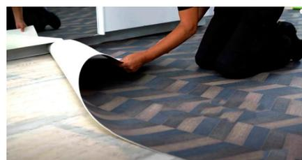
3. Attendez le temps de séchage recommandé, puis repositionnez le revêtement de sol sur le sous-plancher préparé.
