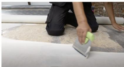
2. Appliquez l'adhésif sur le sous-plancher conformément aux instructions du fabricant de l'adhésif.
